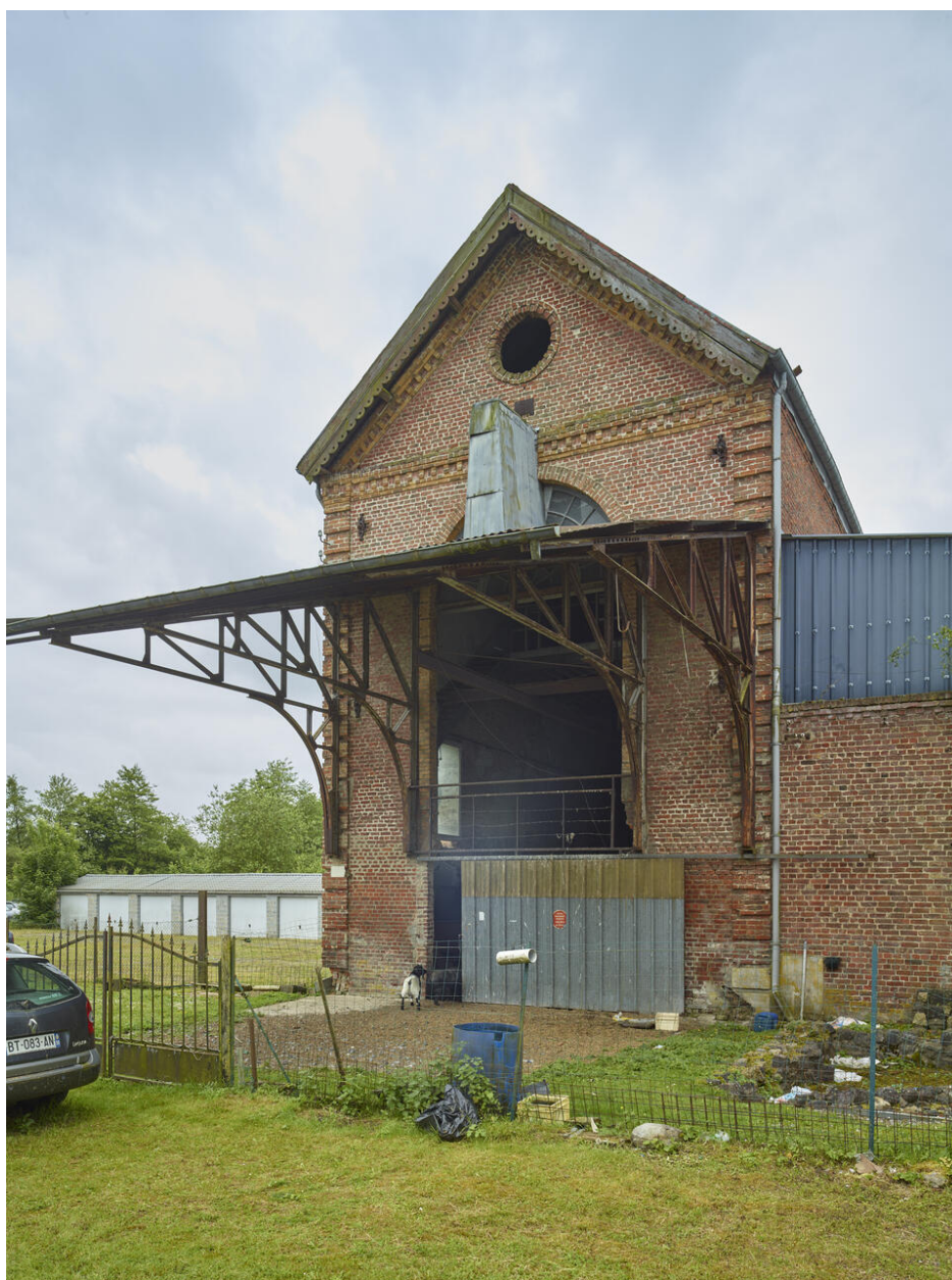
Pignon nord de l'ancien bâtiment de la machine à vapeur.
