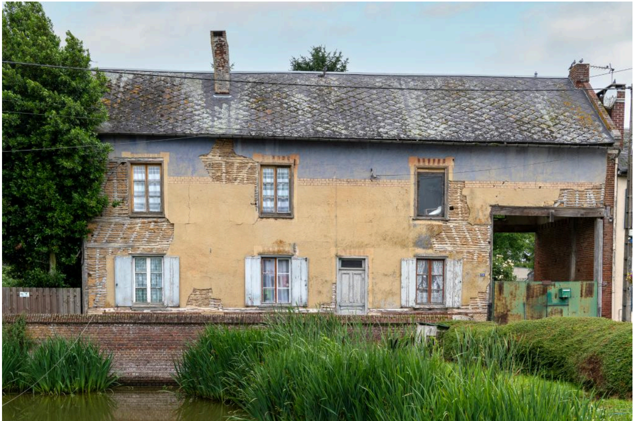
Logis en pans de bois torchis avec entrée charretière, n°50 rue Principale, vue depuis l'est.
