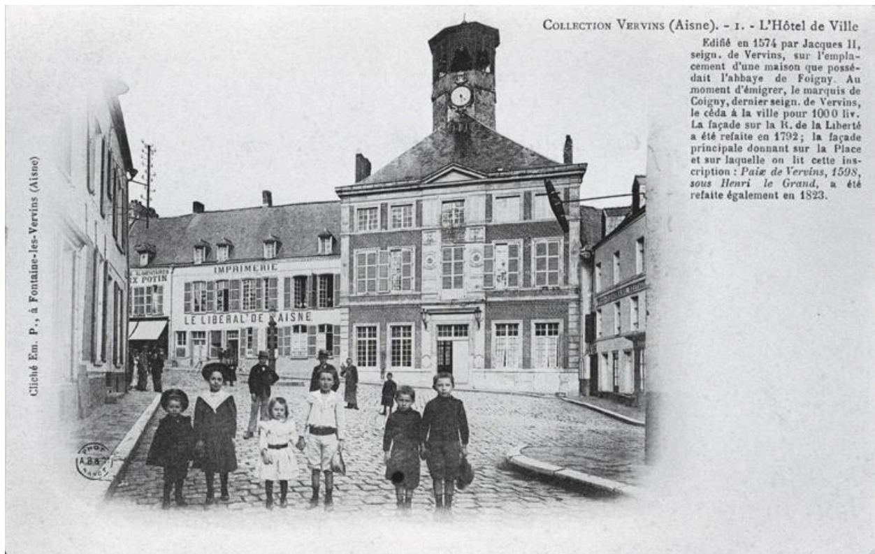
Vue ancienne de la façade de l'hôtel de ville.
