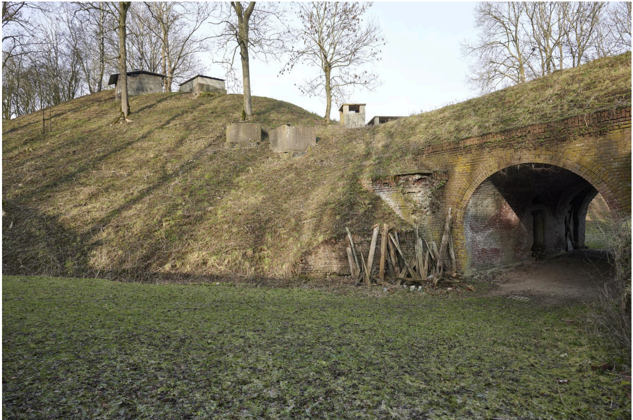
Cour est. Couvert du magasin à poudre ouest.
