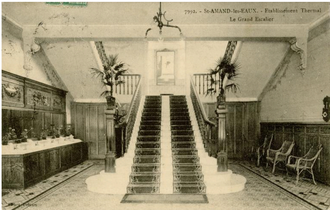
Le hall et le grand escalier, carte postale (Médiathèque Saint-Amand-les-Eaux).
