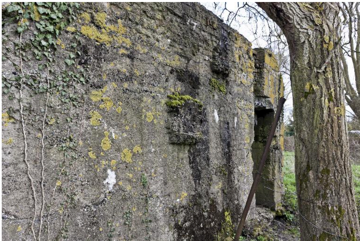
Élévation Sud-Ouest. Au fond l'accès au couloir de distribution
