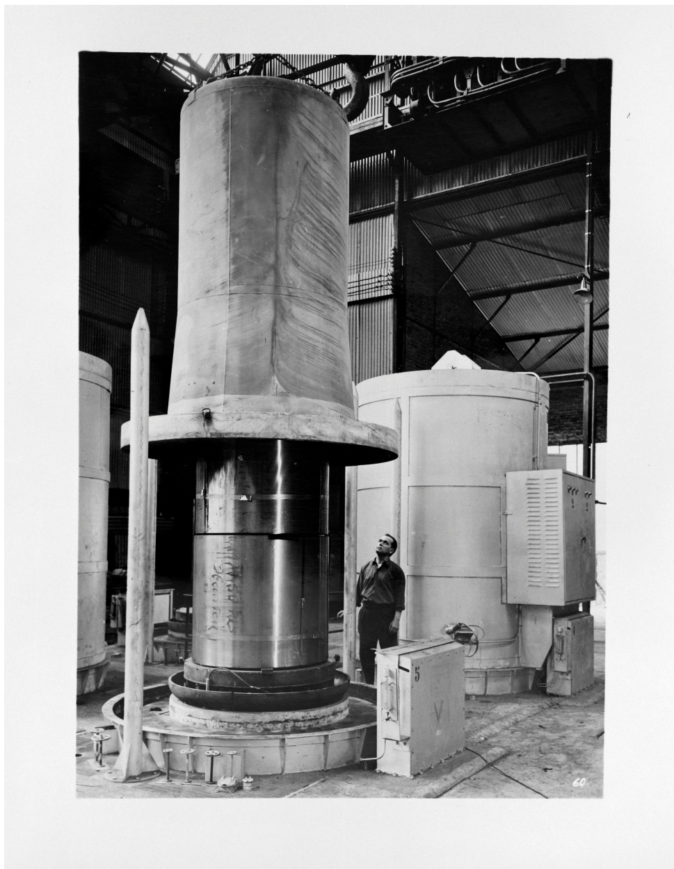
Atelier de recuit des tôles en cloche mis en route en 1961 (?). Photographie ancienne, auteur inconnu, sans date (coll. part.).
