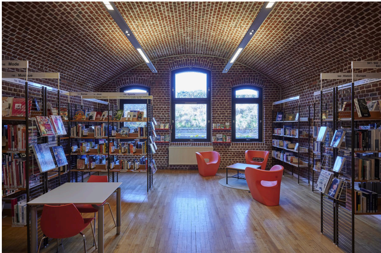
La caserne de tête transformée en médiathèque. Vue transversale du premier étage.
