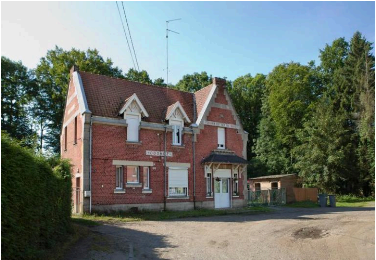
Vue générale depuis la place de la gare.
