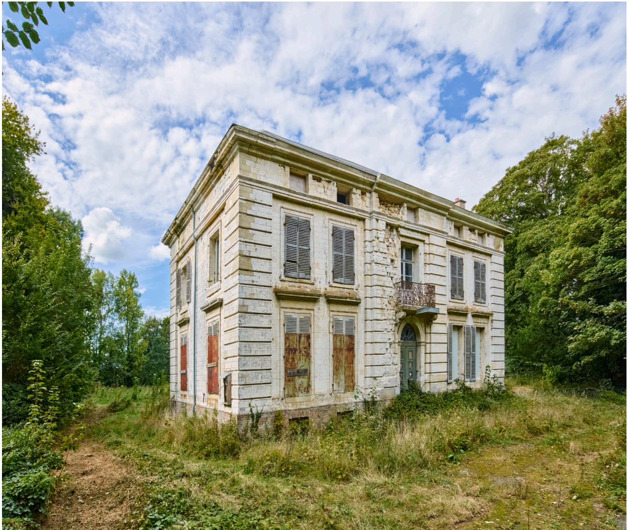
Vue de trois quarts depuis la cour.
