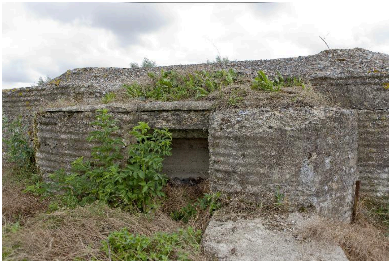
Entrée, vers le sud-est
