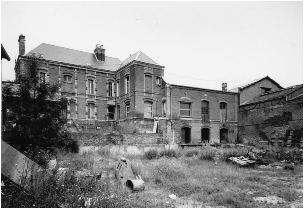
Le logement patronal, les bureaux et l'ancien magasin, vus depuis la cour au sud.
