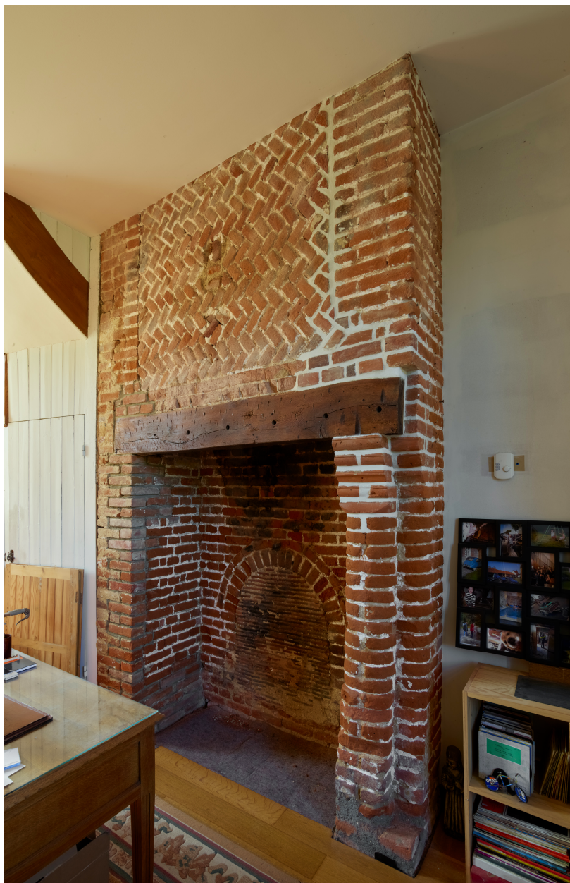
Cheminée, intérieur du manoir.
