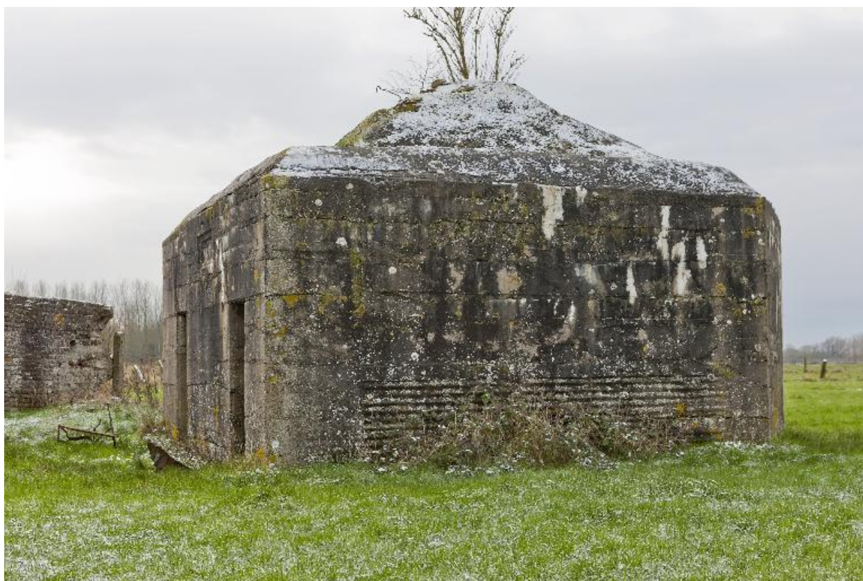
Casemate nord, vue vers le sud-ouest
