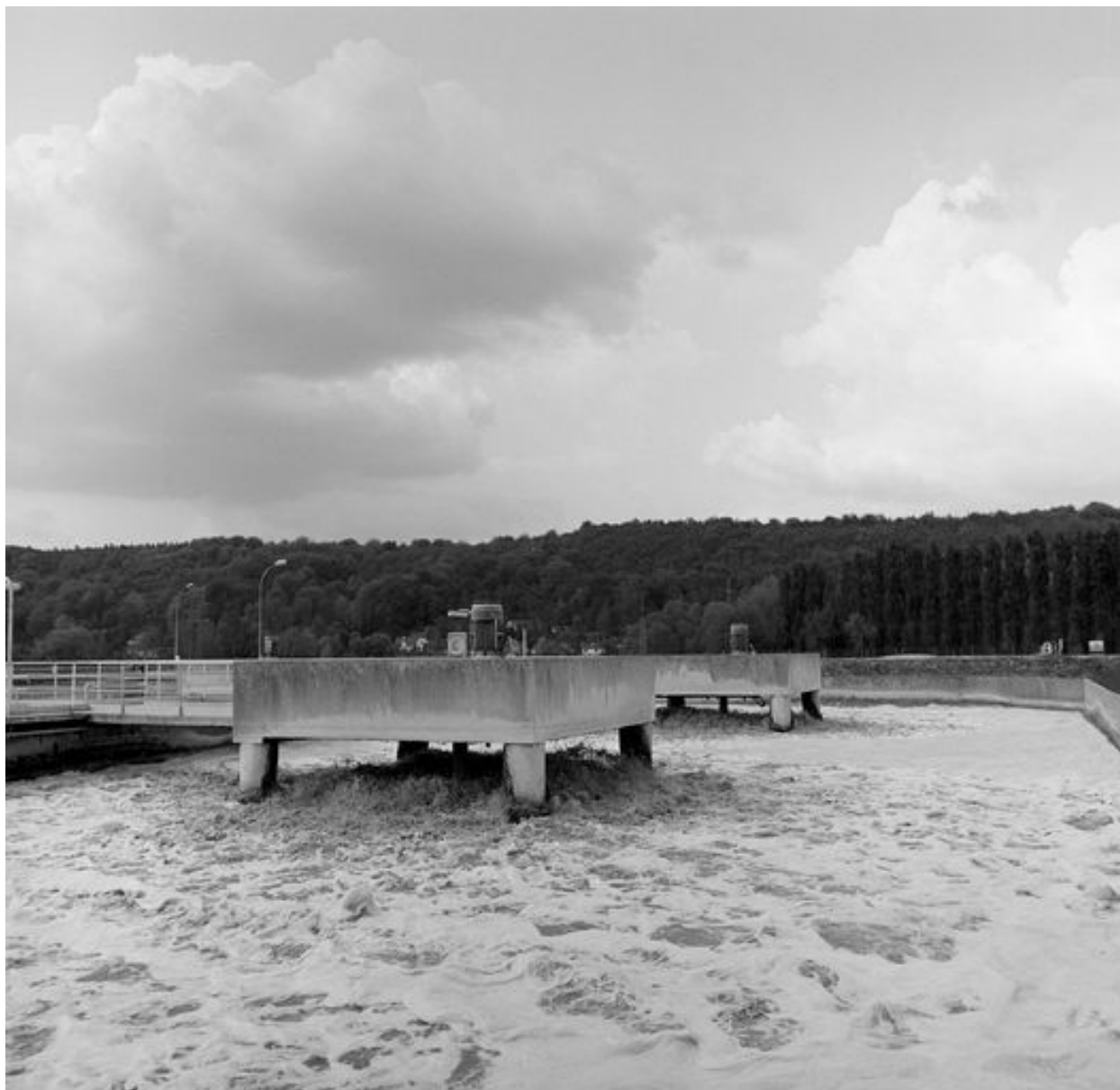
La station d'épuration construite vers 1970.
