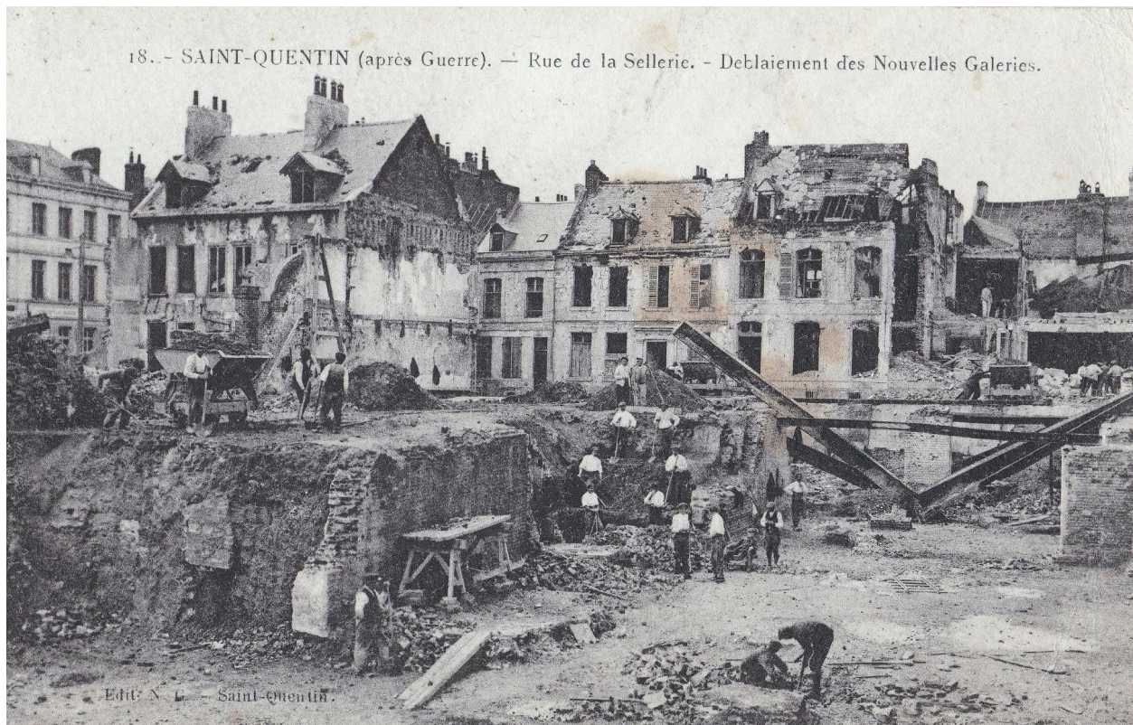
Saint-Quentin, rue de la Sellerie. Déblaiement des Nouvelles Galeries, carte postale, vers 1920 (coll. part.).
