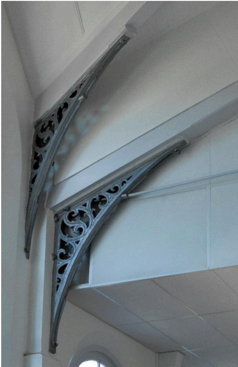
Vue des corbeaux en fonte à l'intérieur de la gare.
