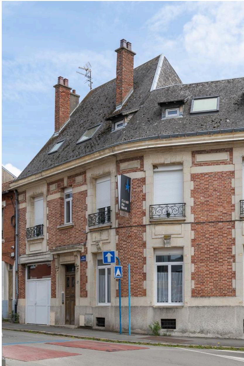
Façade de la maison du directeur et première travée de la façade de la banque depuis la place Sadi-Carnot.
