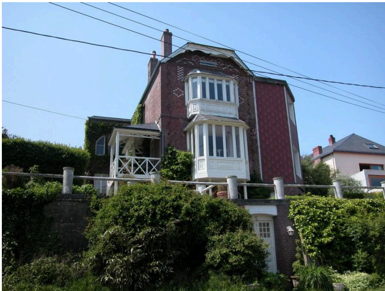
Vue d'ensemble, élévation côté mer.
