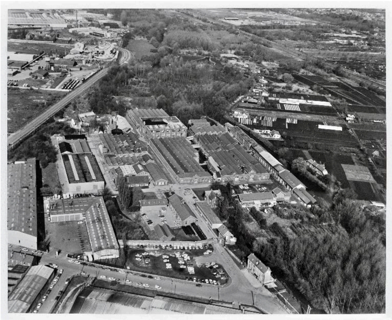
Vue aérienne de l'usine dans les années 1980, depuis l'est (AP).
