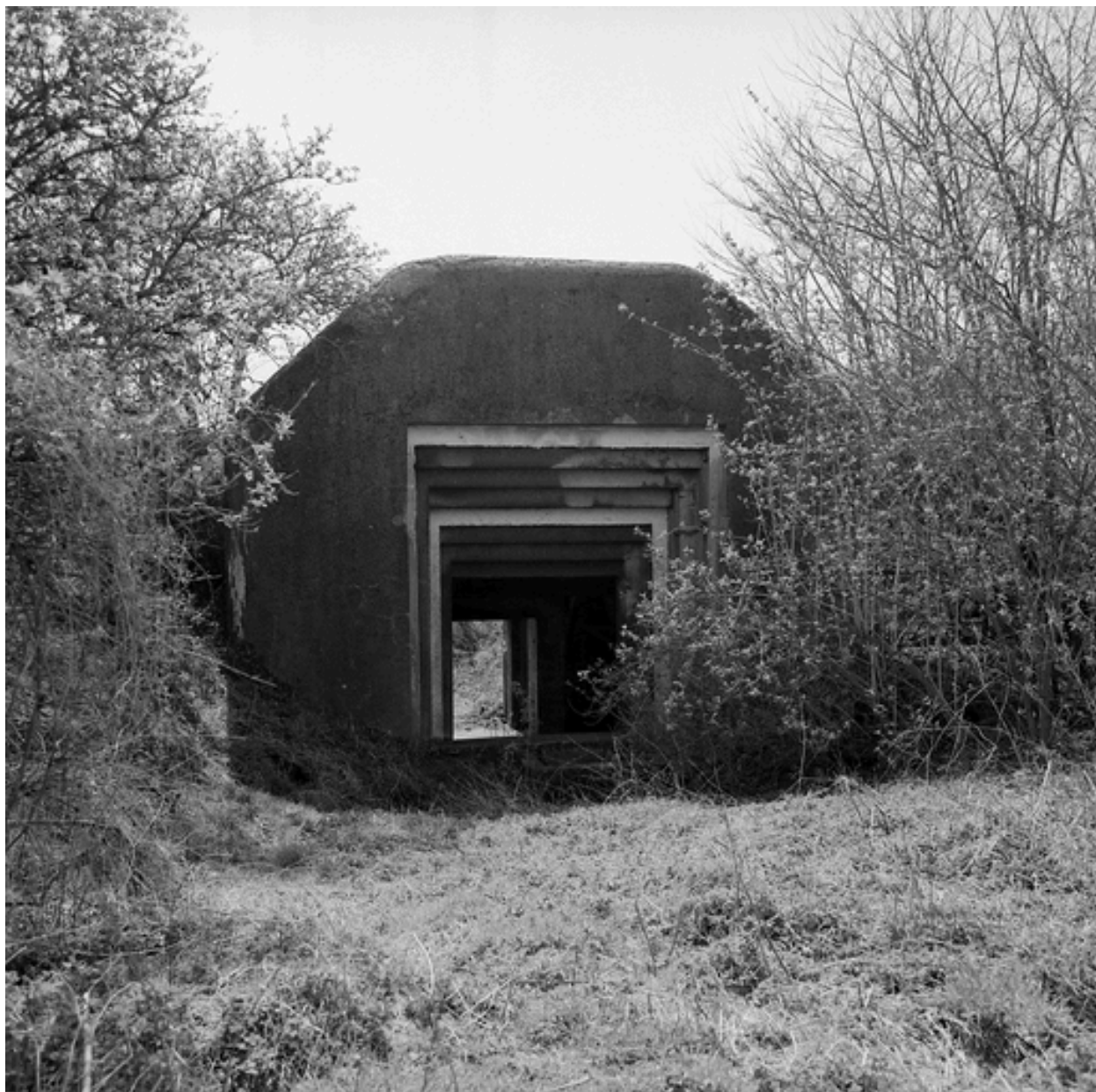
Vue générale depuis le nord.
