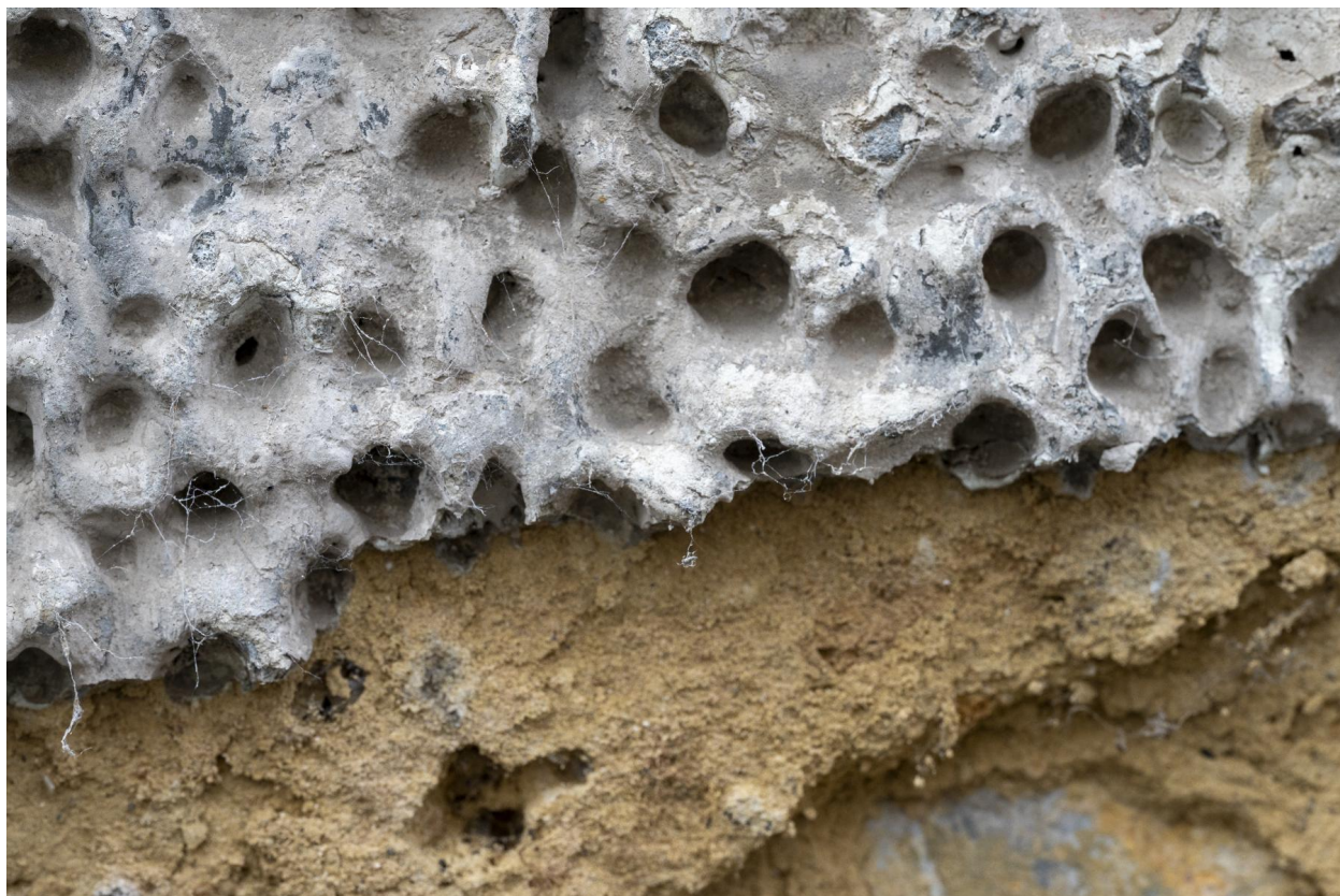
Enduit nid d'abeille : détail de la structure, de type "torchis" (maison, 5, rue des Lombards).
