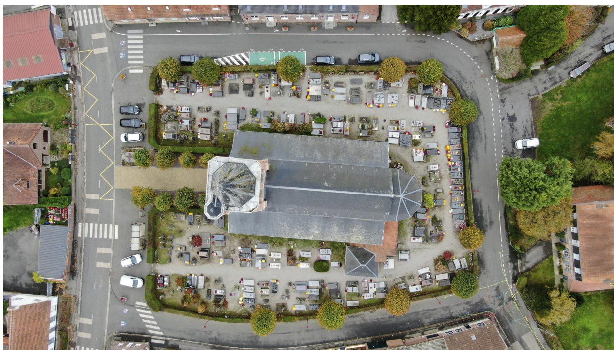
Vue zénithale de l'église.
