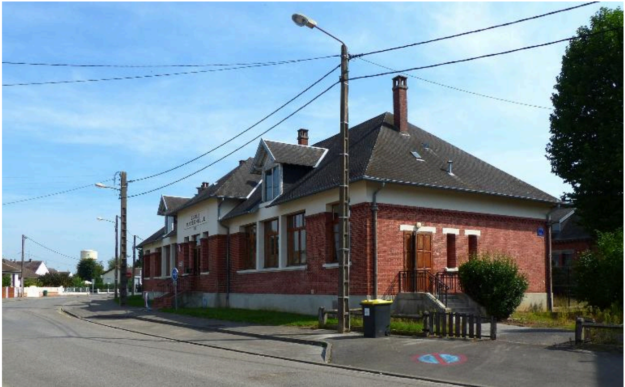
Vue depuis le boulevard des Déportés.
