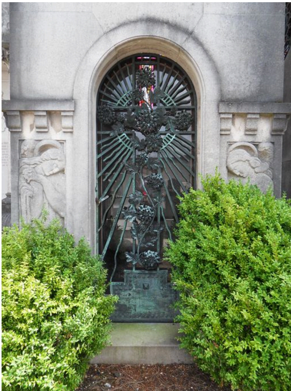
Vue de détail de la porte.
