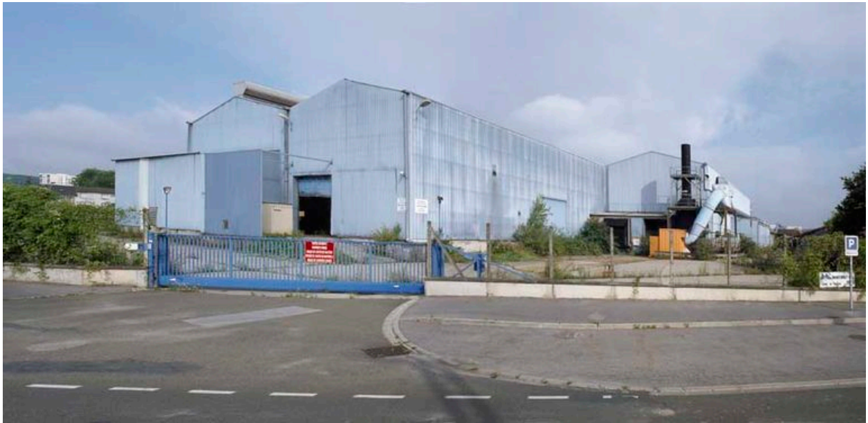
La fonderie depuis la rue des Frères-Péreaux.
