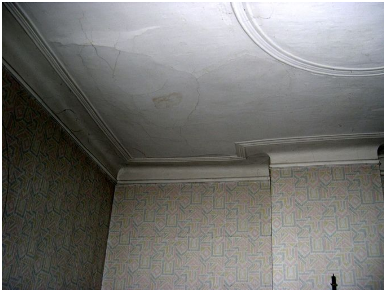
Intérieur, rez-de-chaussée, pièce nord-ouest : plafond, vue partielle.
