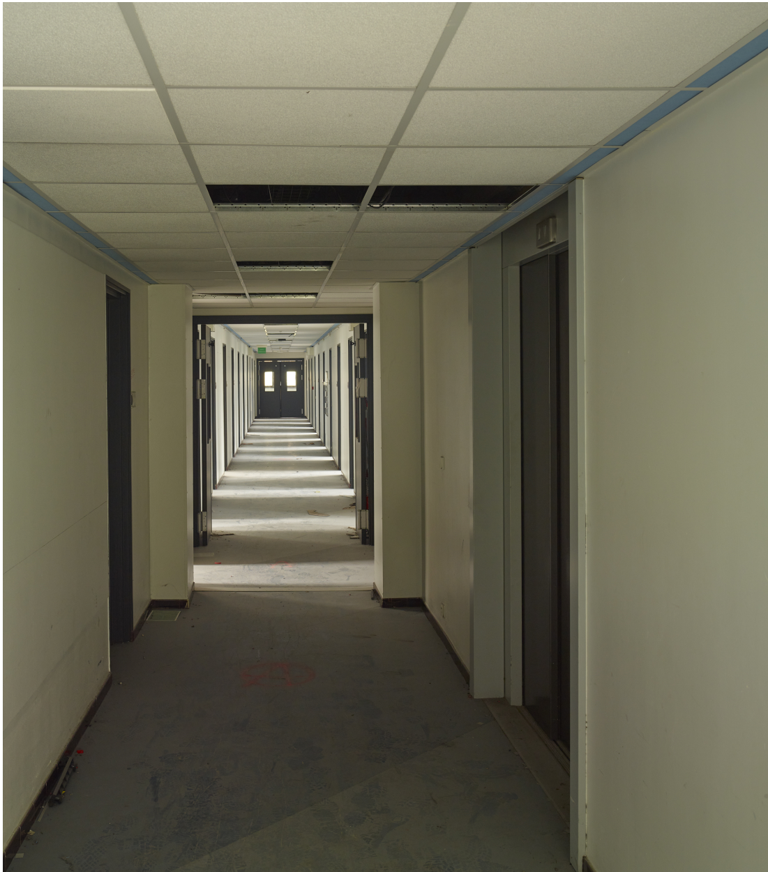
Bâtiment provisoire dit R8 : vue du couloir desservant les bureaux.
