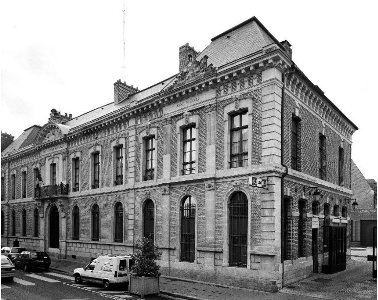
Vue du bâtiment sur rue, depuis le nord-ouest.
