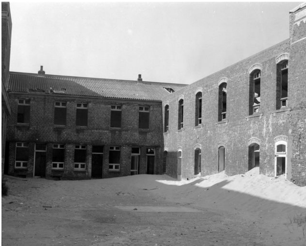
Détail de deux façades donnant sur la cour.
