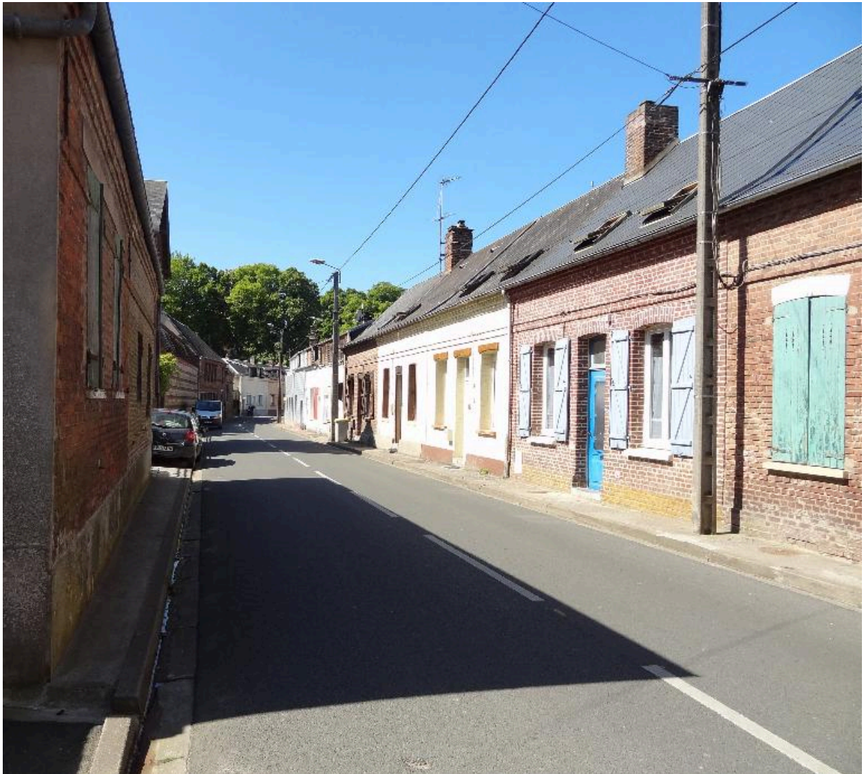
Ancienne cité ouvrière Gaudefroy-Caqueret, rue Jean Catelas.
