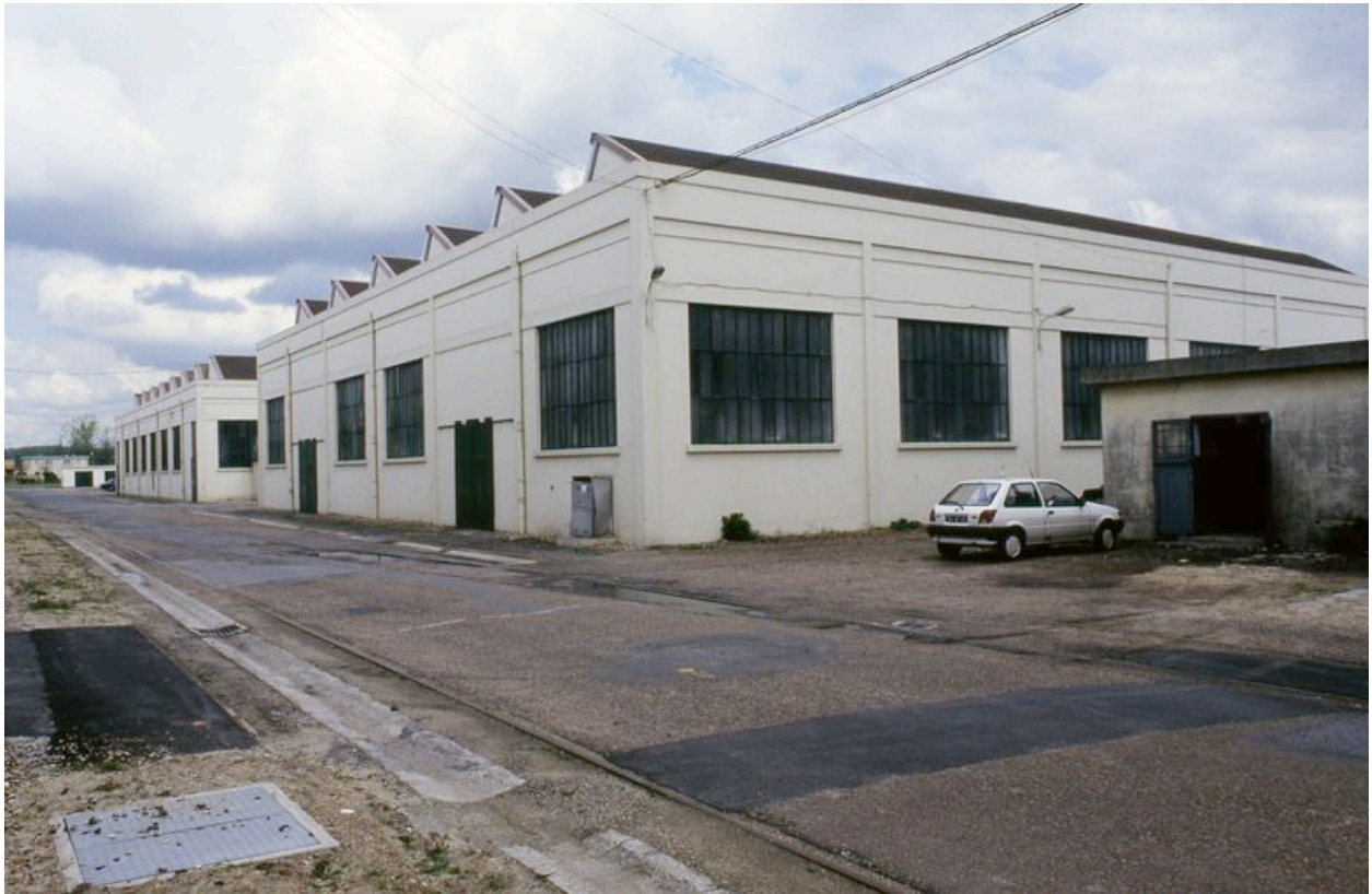
Atelier des enduits et d'entretien.
