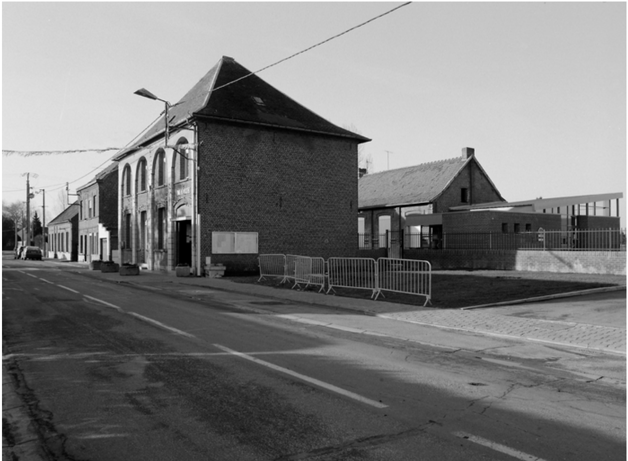
Vue générale de trois quarts, élévation antérieure.
