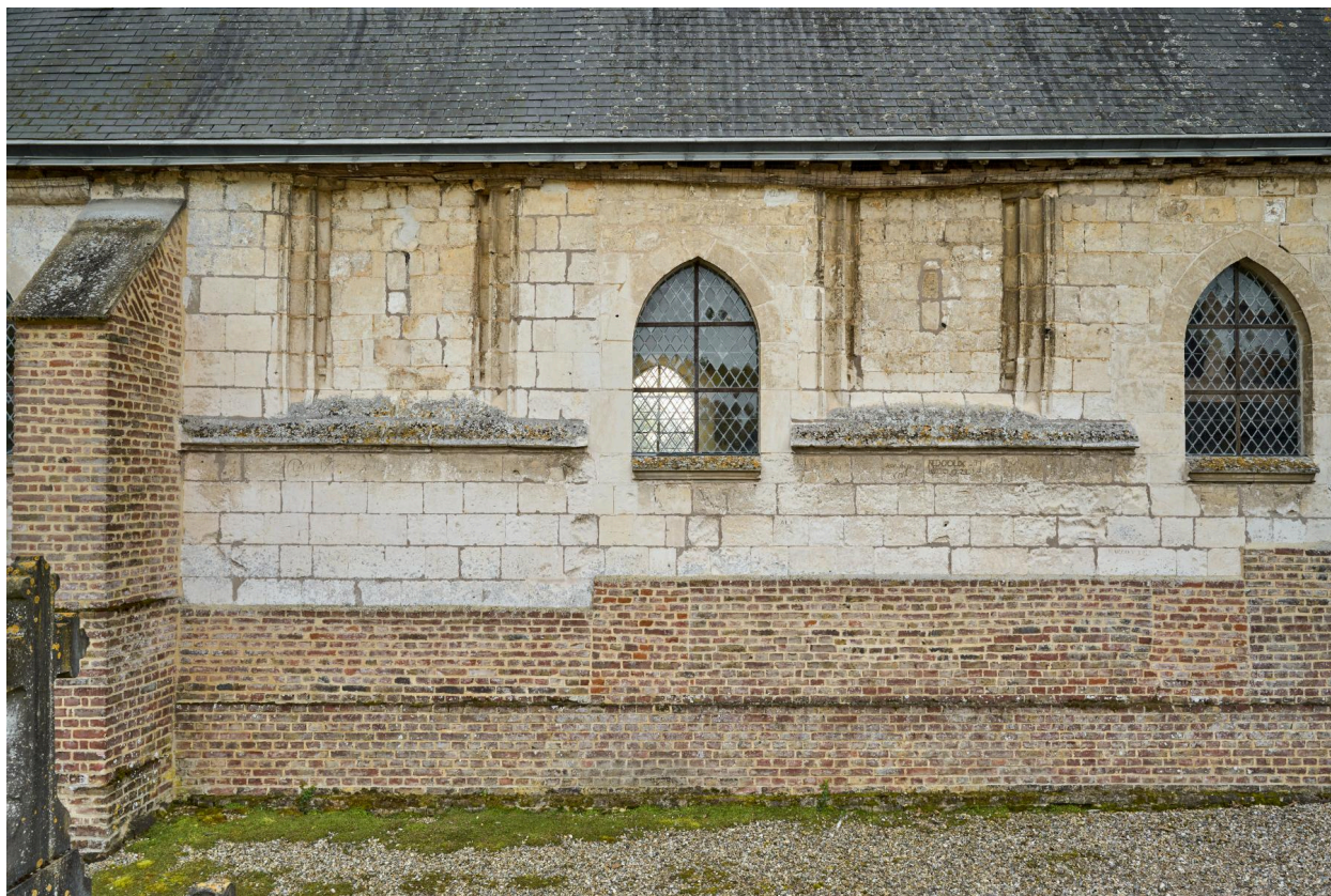
Détail de l'élévation nord.
