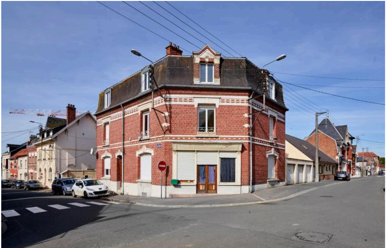
Vue générale sur le pan coupé et les façades rues Jean-Baptiste-lequette et Gambetta depuis la rue Gambetta.
