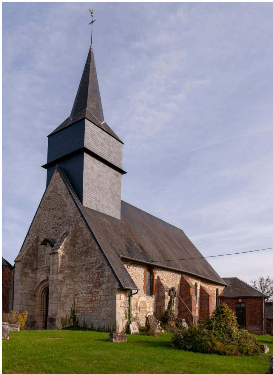
Vue de l'église depuis le nord-ouest.
