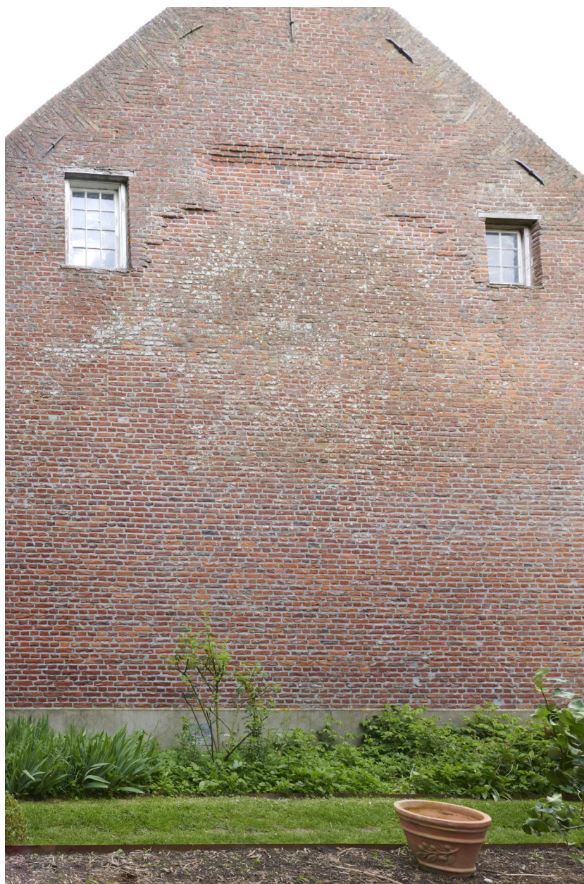
Pignon sud. La forme du pignon originel est encore visible dans la maçonnerie.
