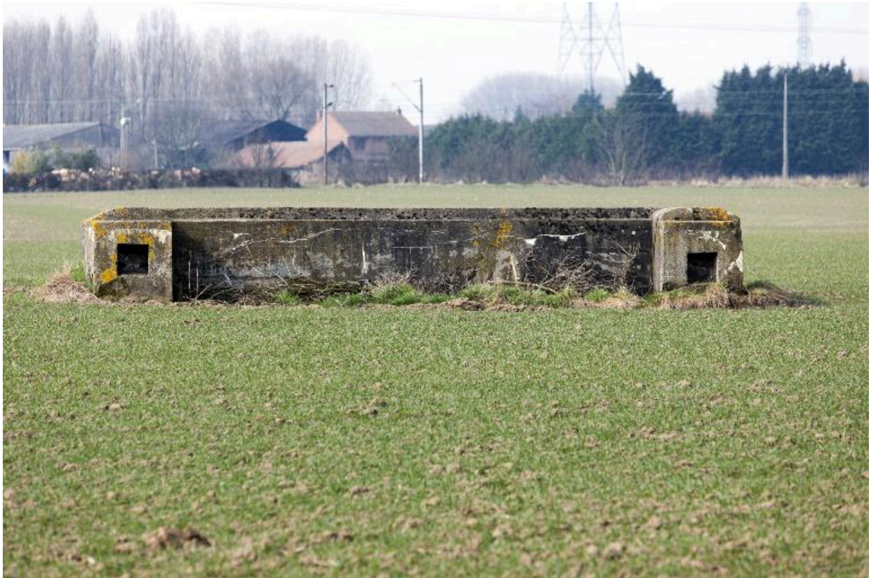
Autre ouvrage en U, vers l'ouest
