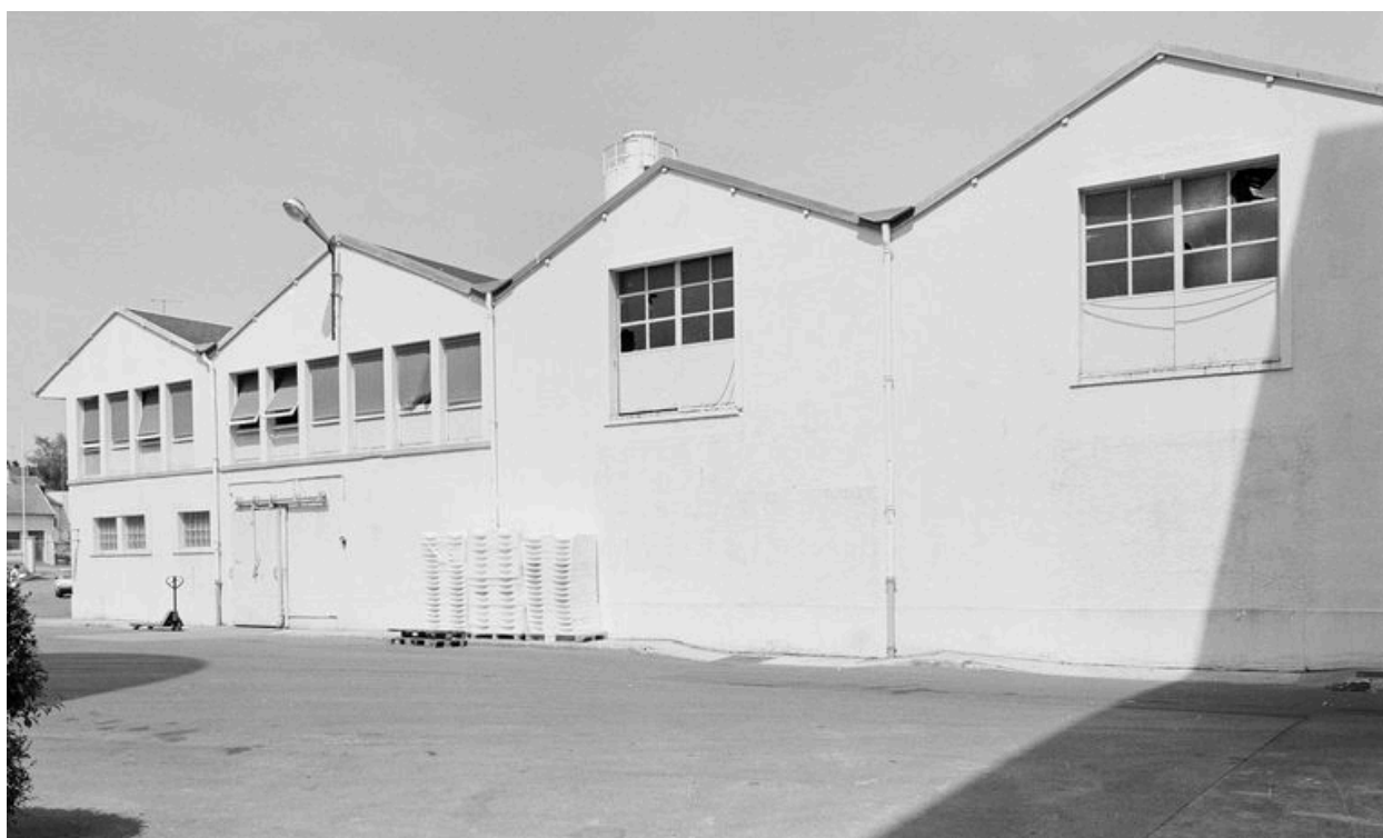
Atelier de fabrication : vue partielle.
