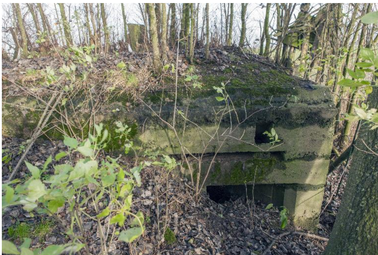
Vue latérale, vers l'est. Ouverture biaise surmontée de la cellule d'éclatement
