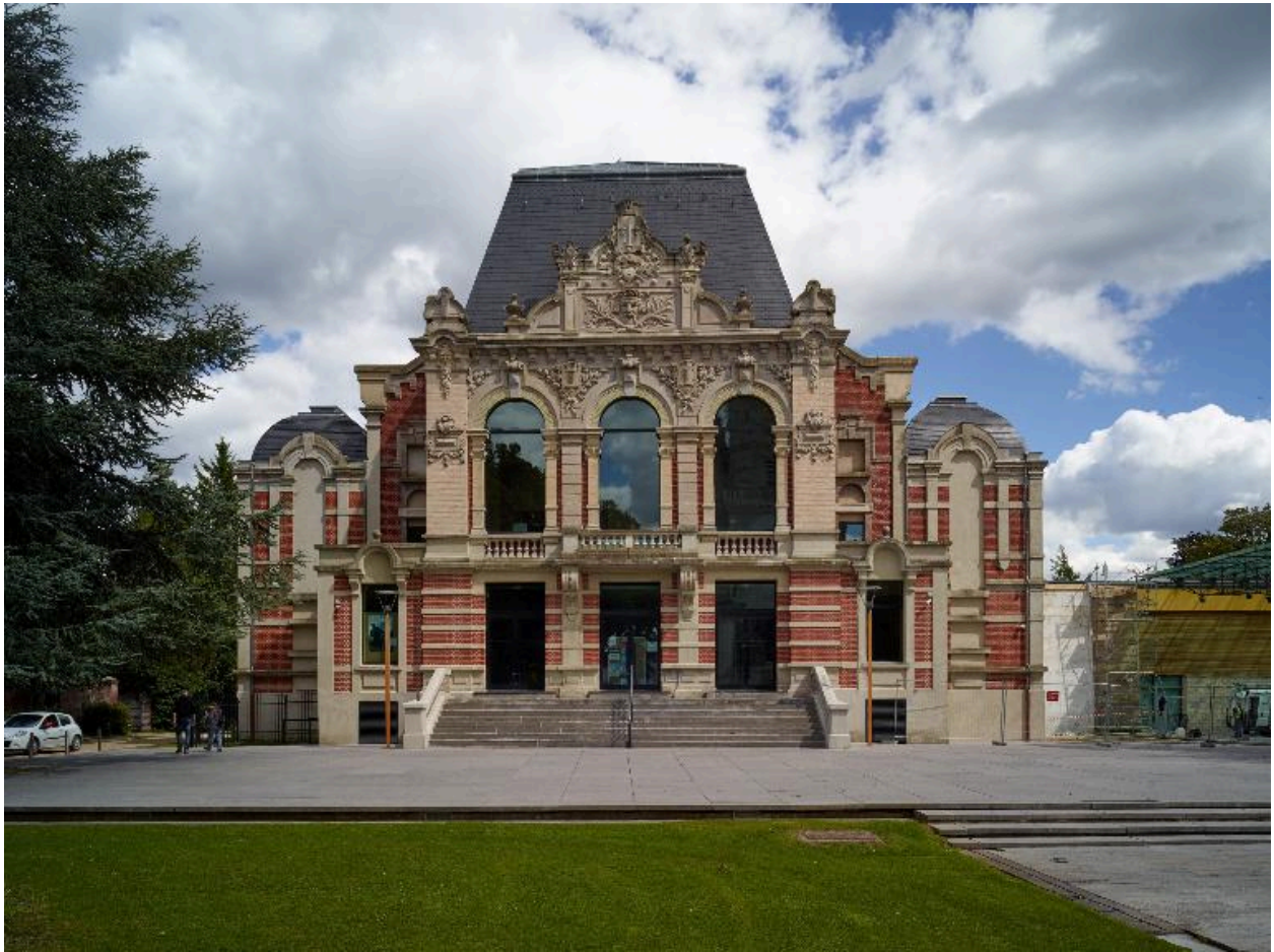
Vue générale depuis le jardin public.
