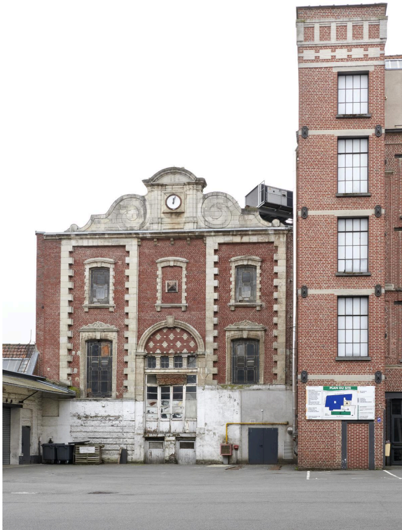
Vue sur la chaufferie adjacente et sur la tour du bâtiment de tissage.
