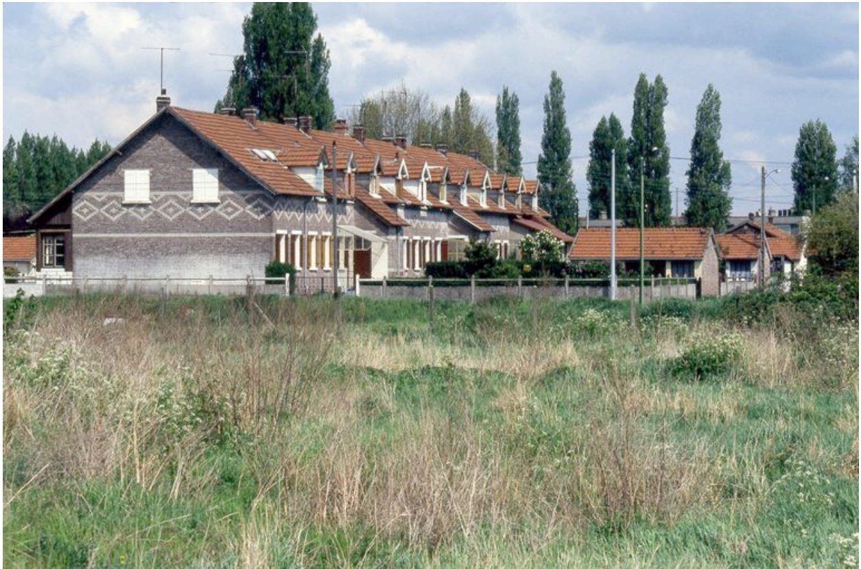
Immeuble à logements ouvriers avec ses jardins et ses remises, vue prise en 1992.
