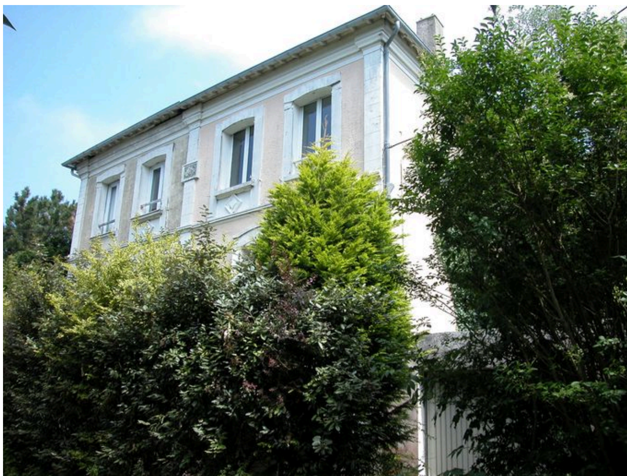
Vue de trois-quarts, façades sud et est.
