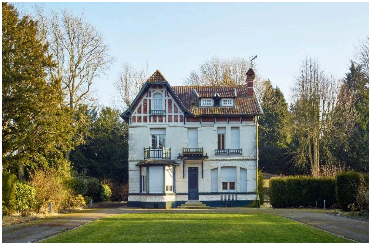
Habitation du directeur, élévation antérieure, vue générale.
