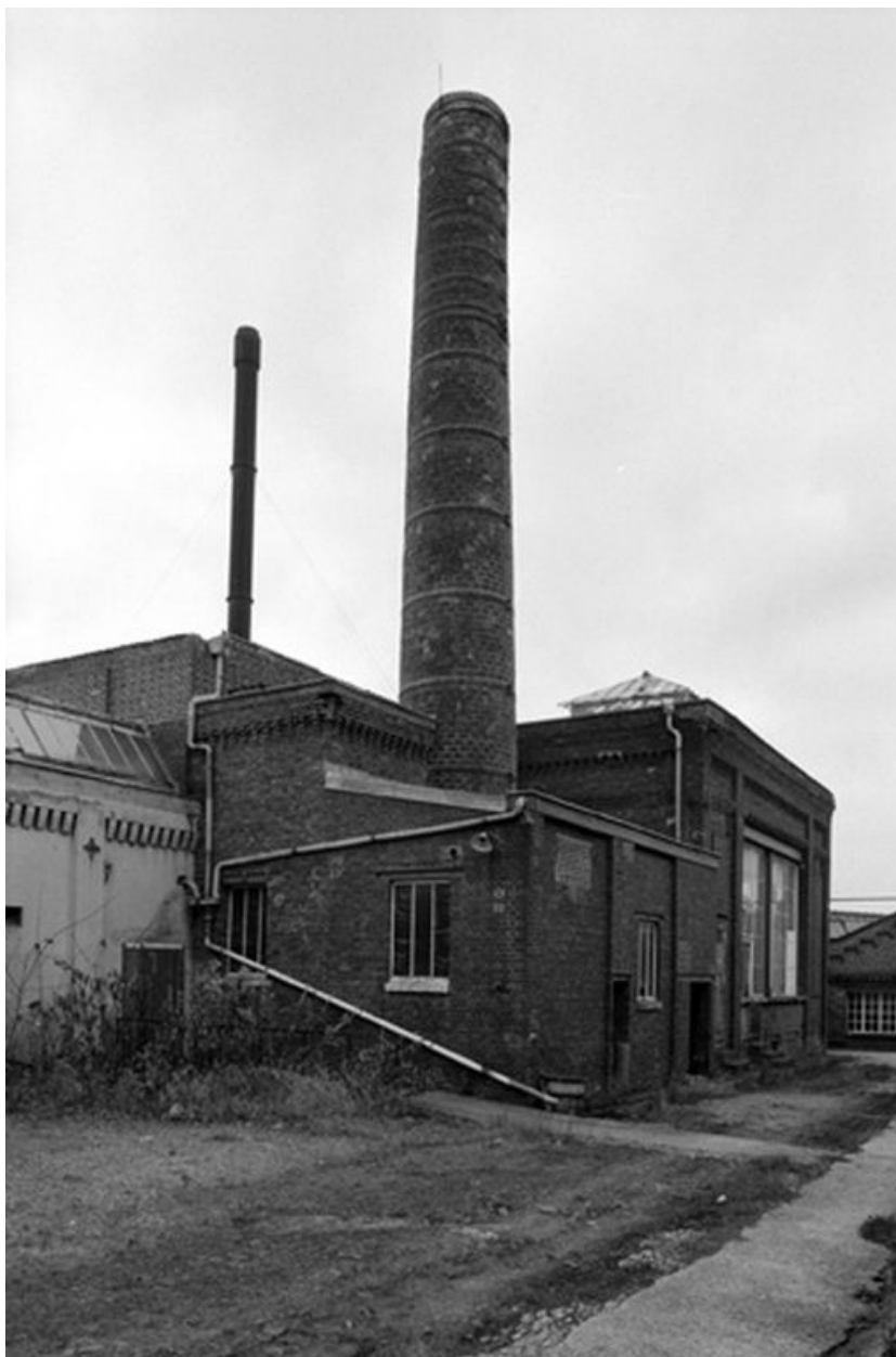
Chaudière, salle des machines et cheminée d'usine, flanc nord-est en 1987.
