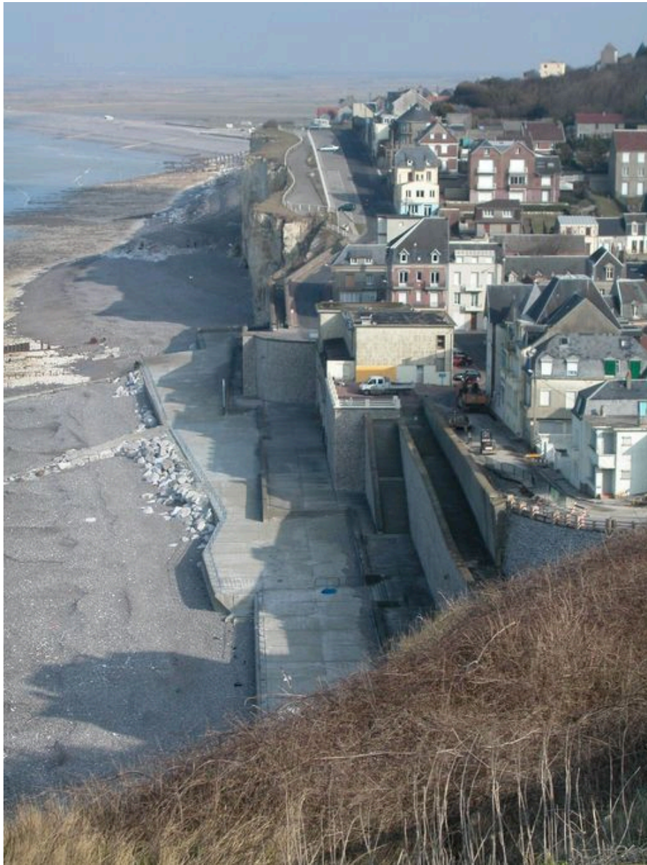
La digue en amont du casino.
