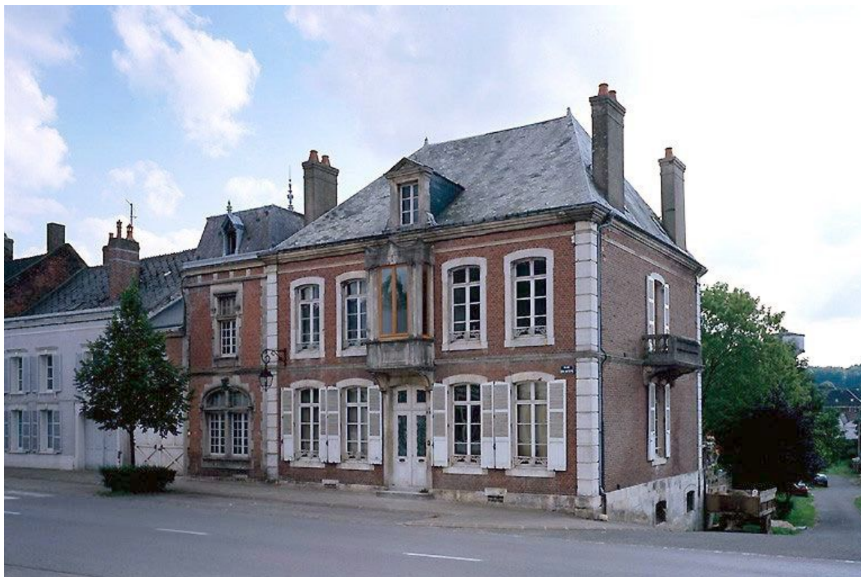
Elévation sur rue depuis le sud-ouest.
