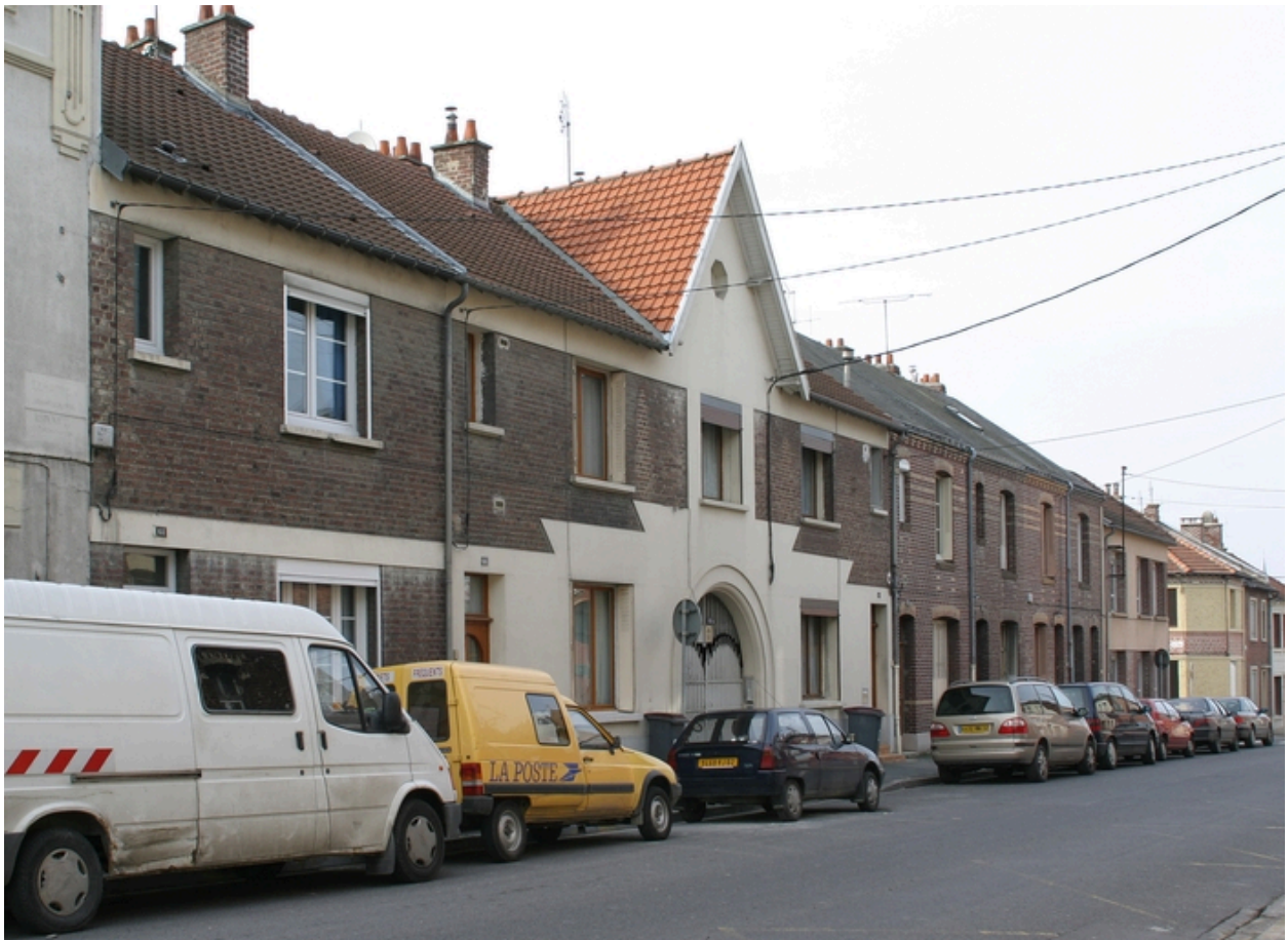
Façade antérieure sur rue.
