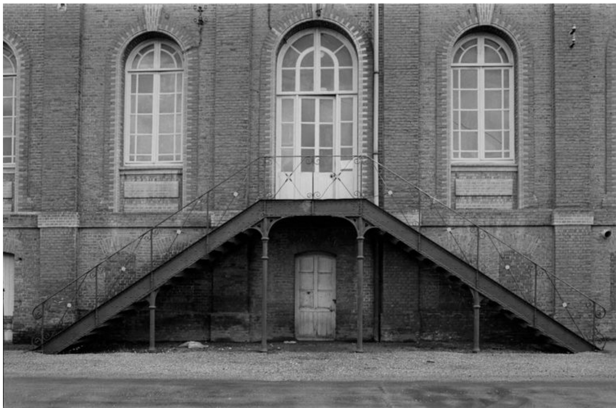
Salle d'essais, en 1983 : détail du flanc nord (Ecomusée du Beauvaisis).
